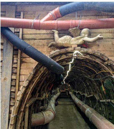
Der Tunnel wird händisch gegraben.
