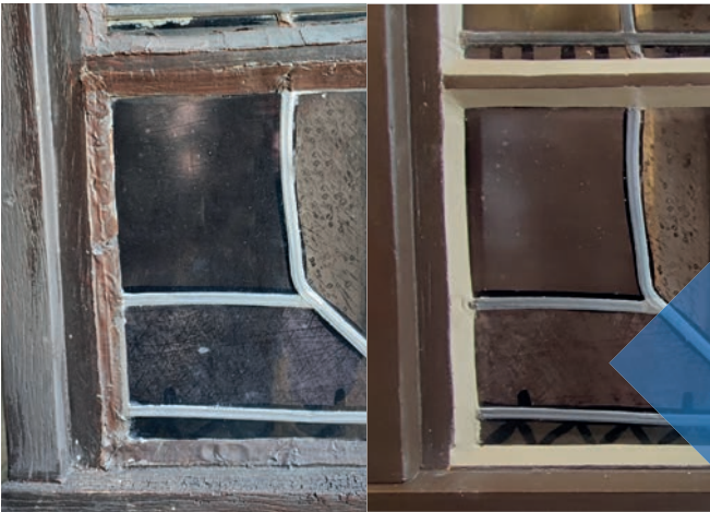
Vor der Sanierung (links) und danach
