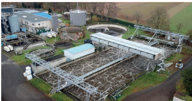
Solarfaltdach in zusammengefahrenem Zustand über Becken
